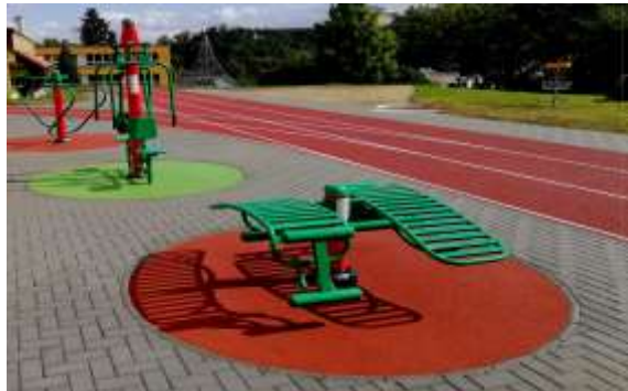
Správné použití bet.obrub.nařezaných délek cca 250mm
