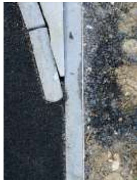
Chybně provedené napojení
