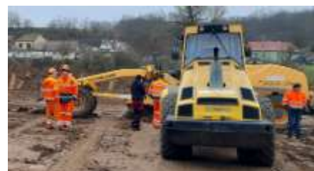
Připadně možno použít vhodnou těžší techniku s vhodnými pneumatikami a velkými poloměry otáčení
