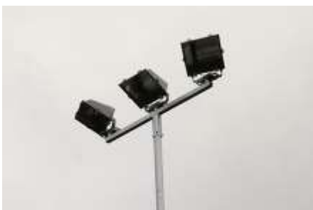
Chybně nasměrovaná asymetrická svítidla
