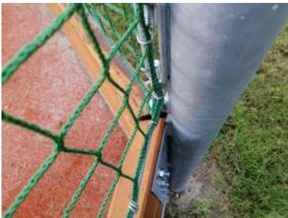
Správně provedený dořez v šikmém rohu hřiště Chybně provedené napojení mantinelu v šikmém rohu
