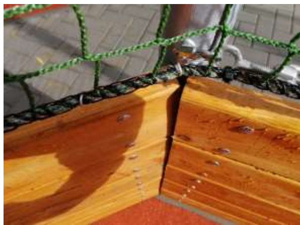
Správně provedený dořez v šikmém rohu hřiště Chybně provedené napojení mantinelu v šikmém rohu
